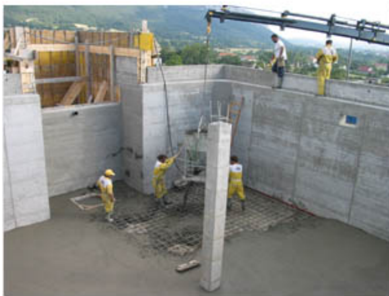
HORMIGONADO SOLERA DEPOSITO, PREVIO HORMIGONADO DE LOS ALZADOS DE LOS MUROS DEL DEPOSITO
