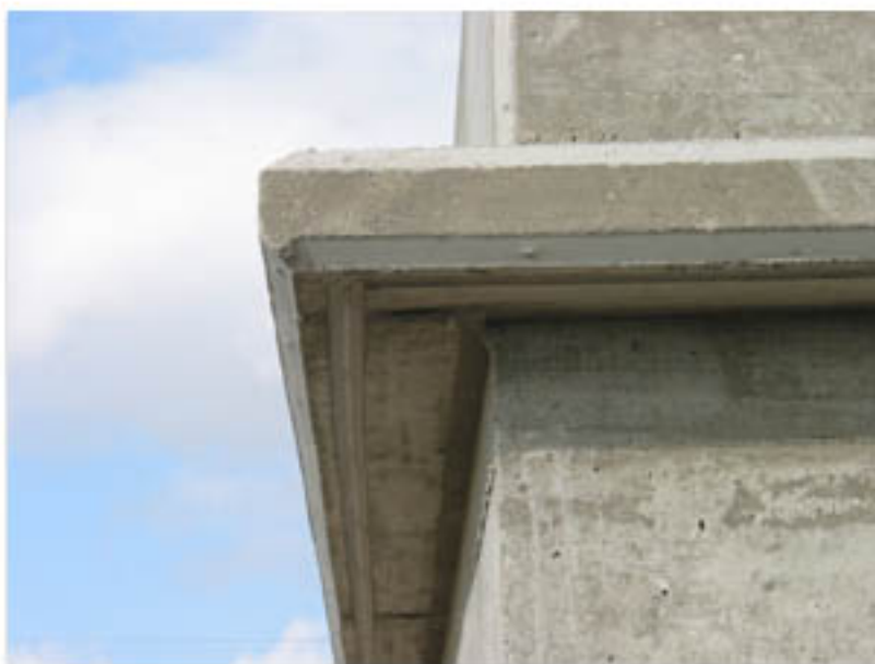
DETALLE DE LA CORNISA DE LA CUBIERTA DEL DEPOSITO
