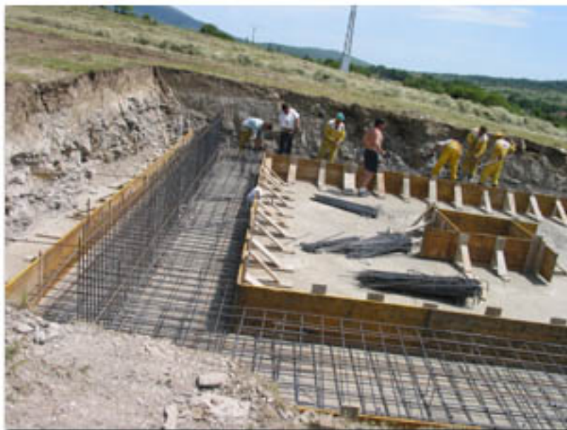
ENCOFRADO Y COLOCACION DE ARMADURA DE LA ZAPATA DEL DEPOSITO
